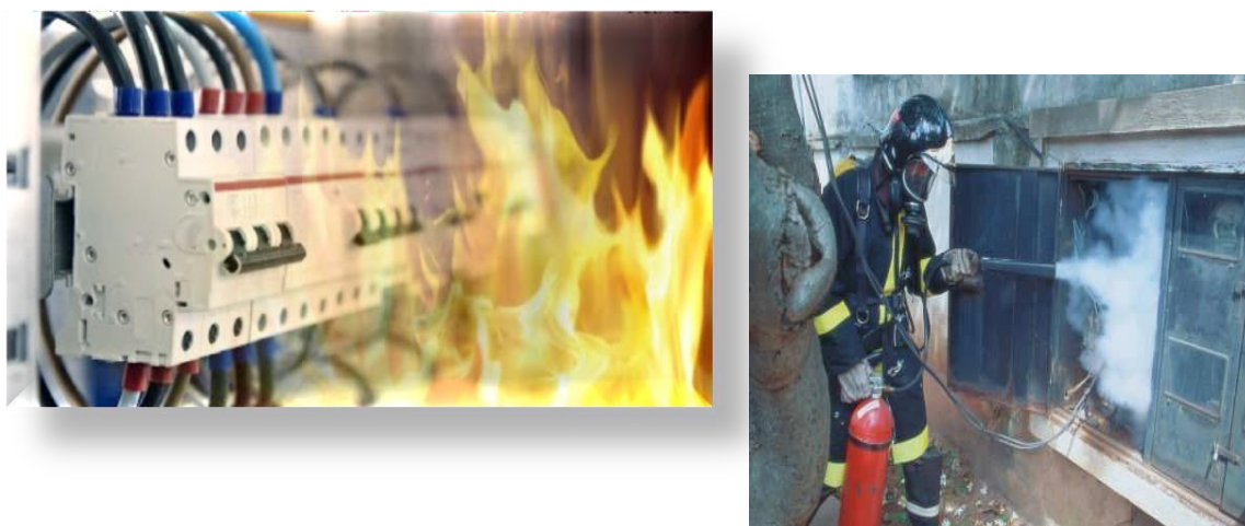
Figura 14 - Equipamento elétrico energizado Fonte: DSCI- CBPMESP
