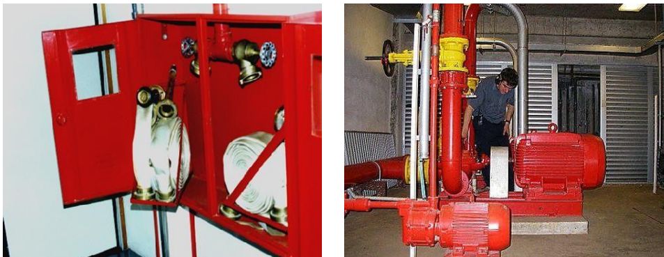
Figura 9 - Sistema Hidráulico (Hidrante e Bomba). Fonte: DSCI- CBPMESP
