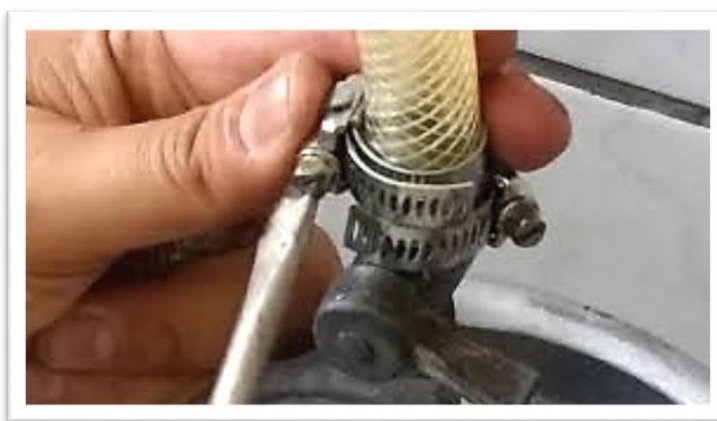
Figura 32 - Maneira improvisada para sanar vazamento causa acidentes Fonte: DSCI - CBPMESP
